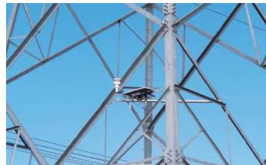
微气象在线监测装置现场安装图
